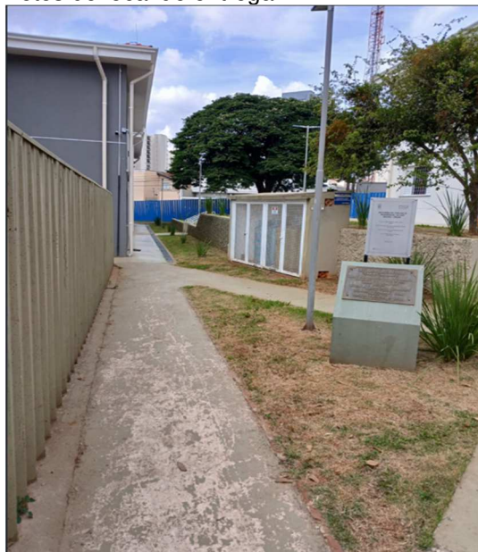
Casa de gás contendo 06 cilindros de propriedade da PUSP-B
